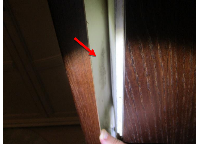
Темные пятна под обоями полотнами на поверхности стен похожие на плесень (грибок).
