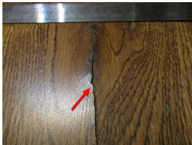
Разрушение облицовочного слоя паркетной доски.
