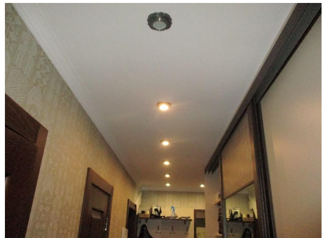
Общий вид потолка
