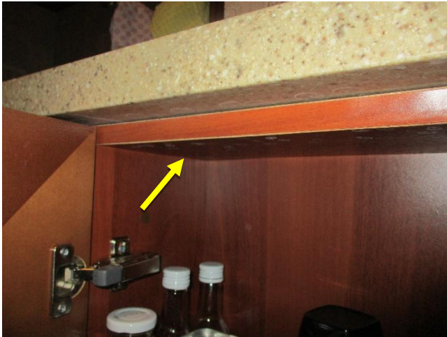
Сухие следы воздействия влаги внутри кухонного гарнитура. Вздутие шпона.
