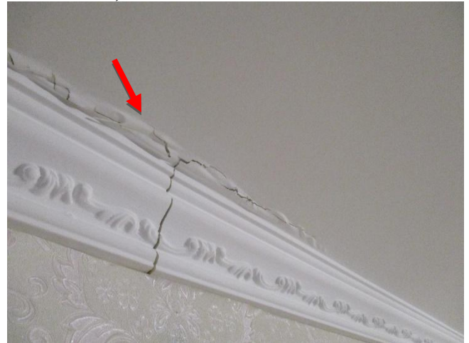
Вздутие и отслоение окрасочного слоя.
